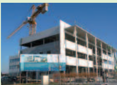
En février, le bâtiment prend forme.
